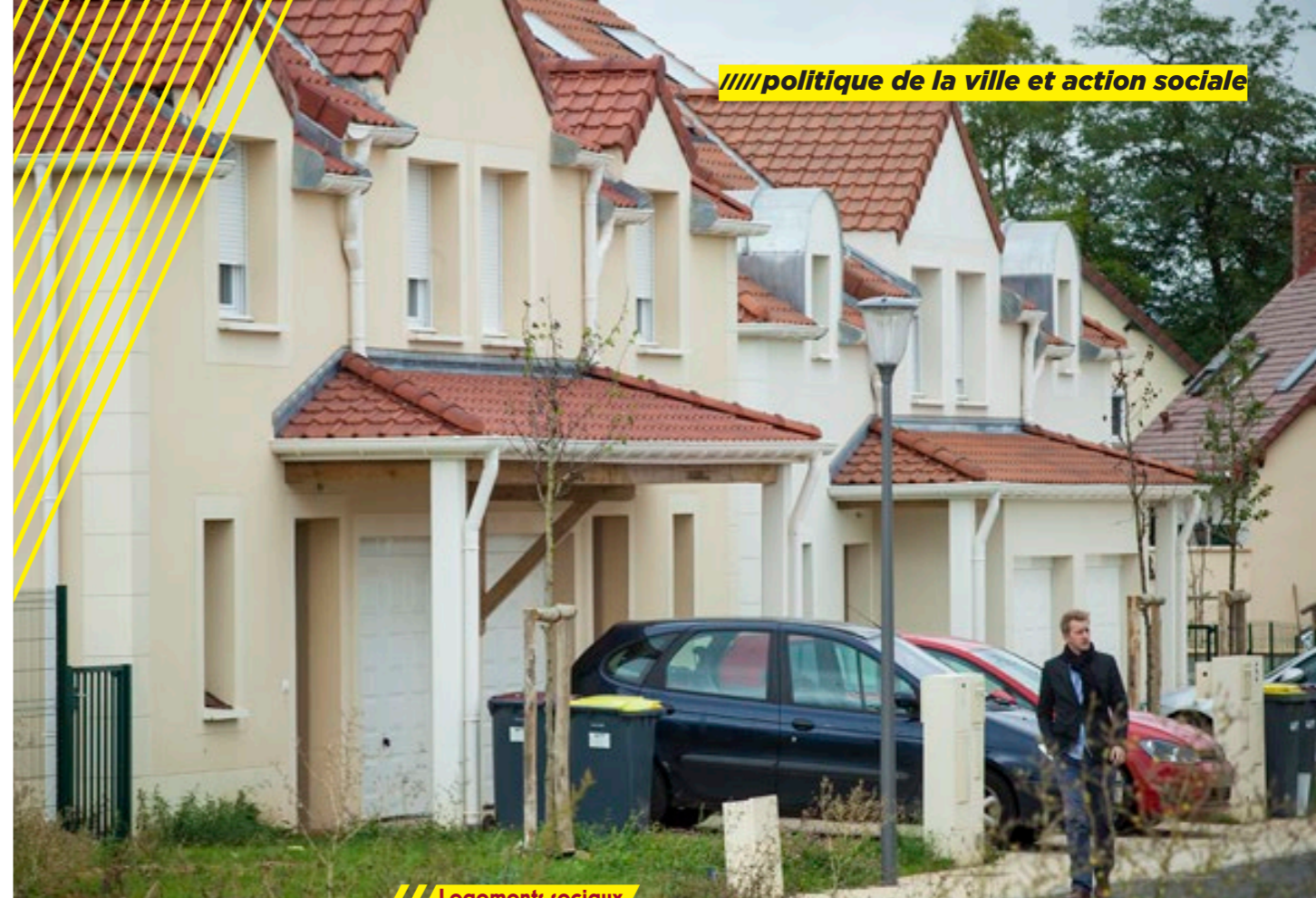
/// Logements sociaux à Gometz-le-Châtel //
