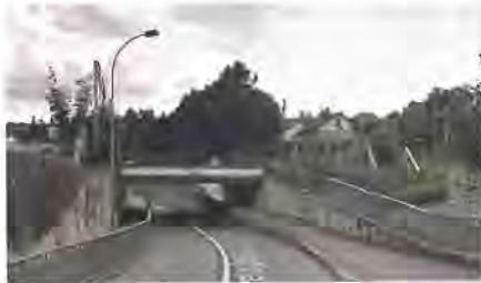
Souterrain au niveau du passage du Villevert
