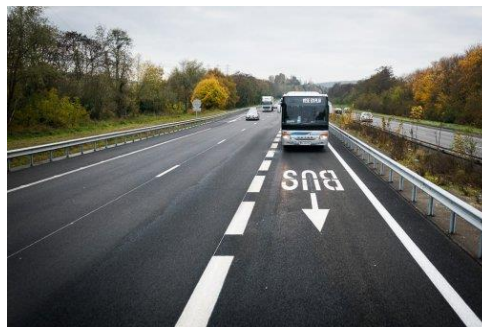
Voie bus dédiée sur l'A10 (source: DIRIF)
