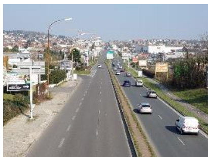
La RN20 dans la traversée de Montlhéry (source : SYSTRA, 2018)
