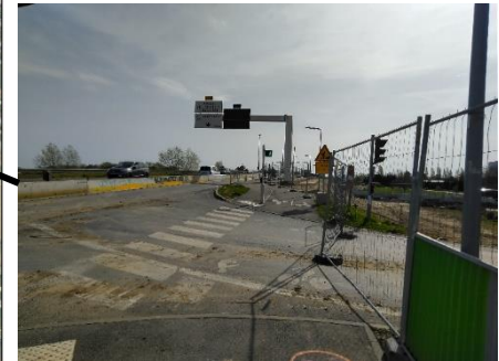
Création d'une passerelle piéton cycle
