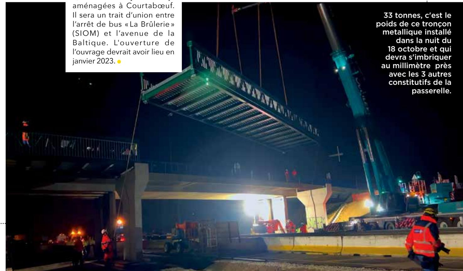
33 tonnes, c'est le poids de ce tronçon métallique installé dans la nuit du 18 octobre et qui devra s'imbriquer au millimètre près avec les 3 autres constitutifs de la passerelle.
